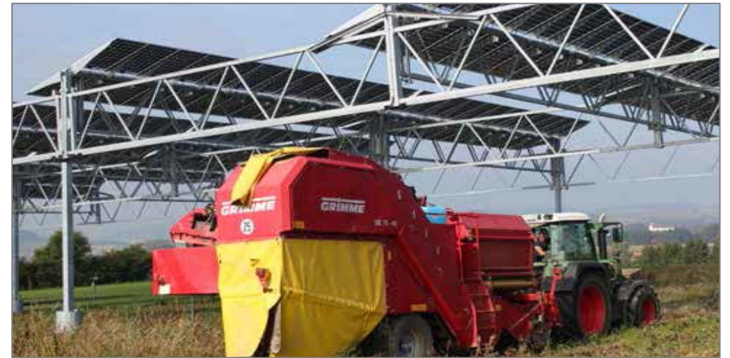
Esempio di impianto agrivoltaico con strutture alte che permettono il passaggio di macchinari per la coltivazione delle patate e di seminativi.
