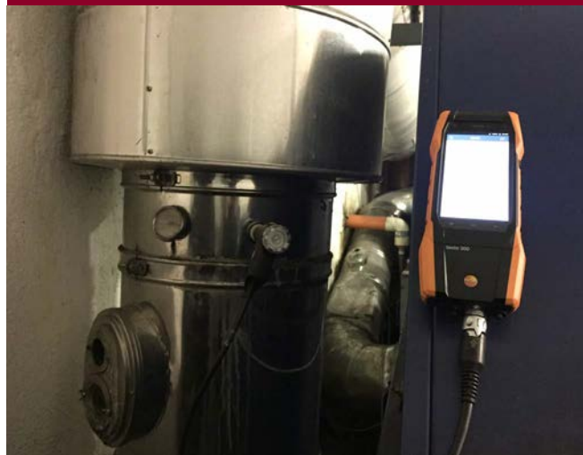
MONITORAGGIO SU CALDAIA CONDOMINIALE A MILANO
