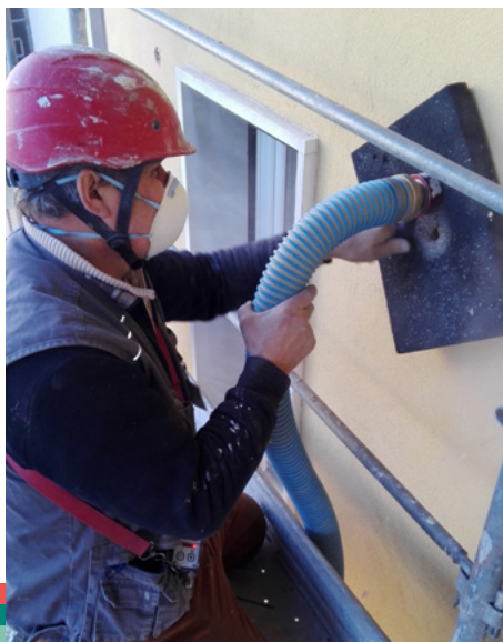
Isolamento dall'esterno e risoluzione del problema di muffa superficiale
